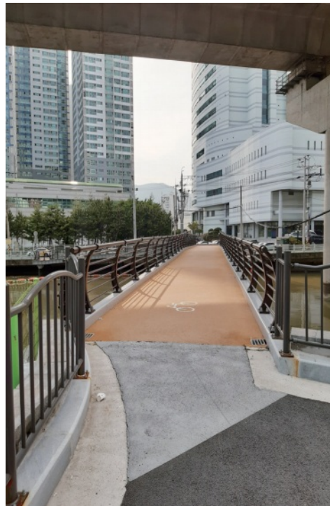
노하다리, 다리 건너 오른편은 동구 범일동 놀원빌딩, 왼편은 한국전력공사 범일변전소 (출처: 광태욱)
