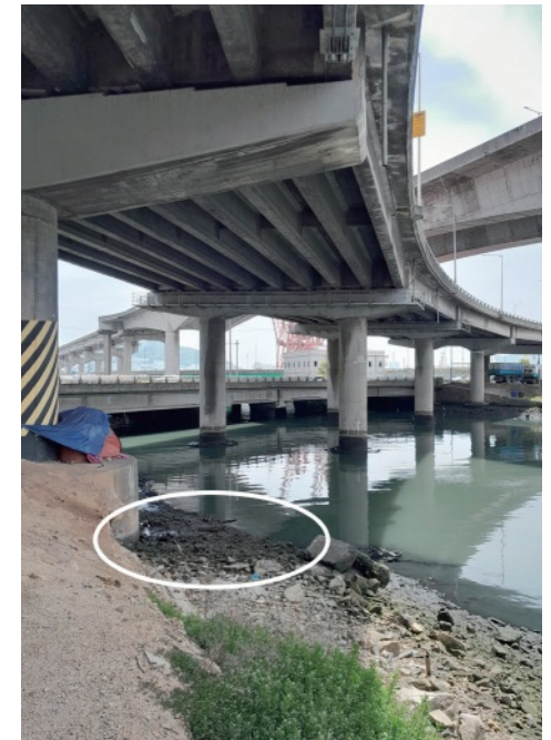
문현동 선착장. 1960년대 중앙동 시청 뒤의 선착장을 오가던 통통배(편리호) 선착장 자리 추정(흰색 원). 교각 밑으로 부두교가 보인다. <출처: 객태욱>
